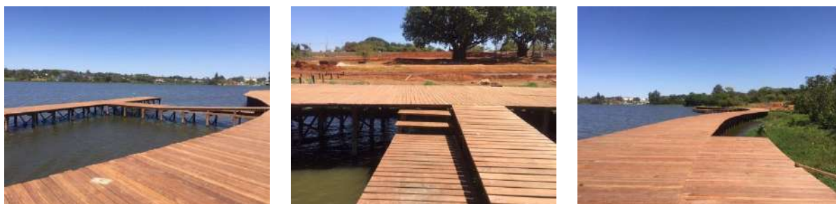
Figura 6 - Calçada da L4 Sul - Deque Sul, junto à ponte das Garças, no Plano Piloto
